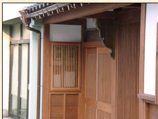
▲ 修景された電気メーターの事例（飛騨市）
