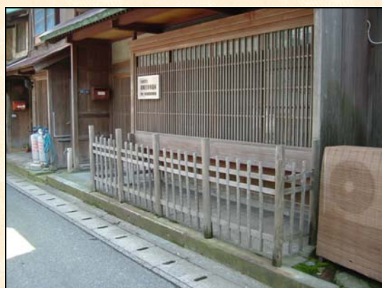
▲ 建築物と一体となった柵の事例
