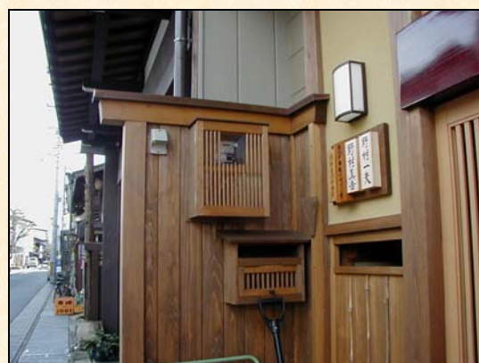
▲ 修景された電気メーター、郵便受けの事例（飛騨市）
