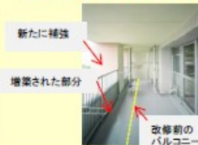
改修前のバルコニー幅
