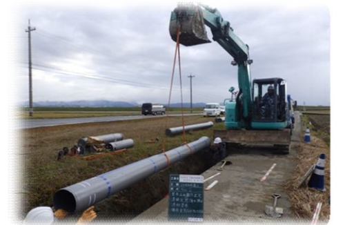
管路布設の様子
