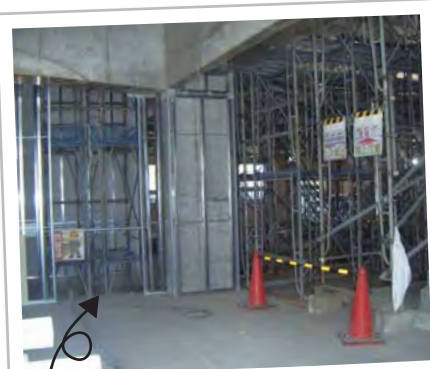
窓付きエレベーター(定員11名) 正面玄関から入ったところ 右側階段
