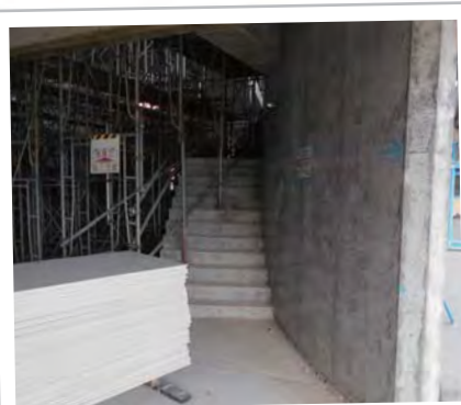
右にゆる～くカーブする階段 コンクリート打ちっばなし壁面
