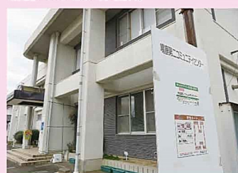
鳴鹿第二コミセン停留所
