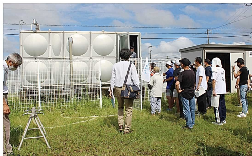
↑受水槽 (貯水槽の一種で水道水を貯めておく施設)
