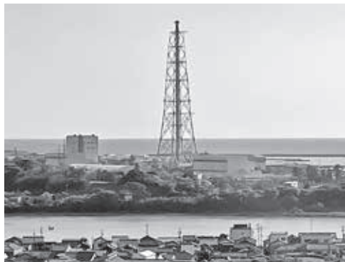
▲ 福井火力発電所
