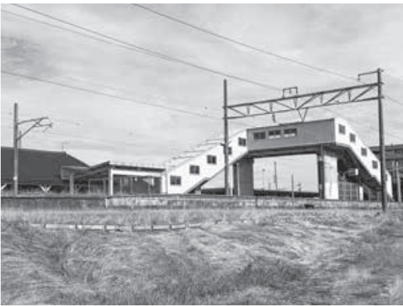
▲ 周辺整備が進む春江駅
