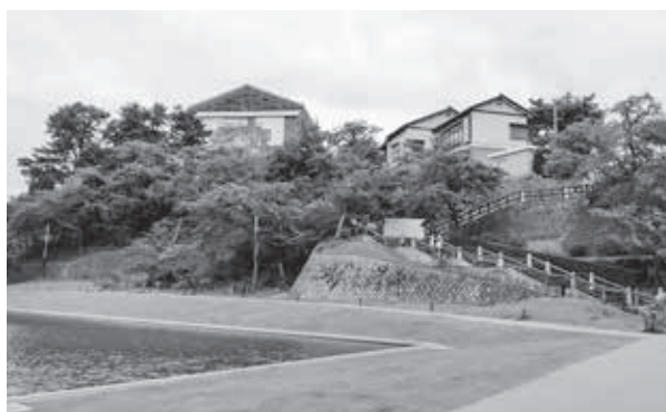
▲ 改修工事が進む素屋根に覆われた丸岡城
