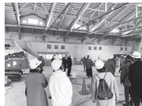
▲ 全天候型子どもの遊び場「さかいキッズパーク」の工事現場を視察する様子（令和8年3月オープン予定：坂井町上新庄地係）
