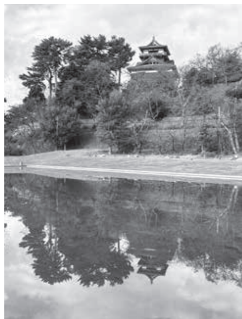
▲ 完成した丸岡城の水盤
