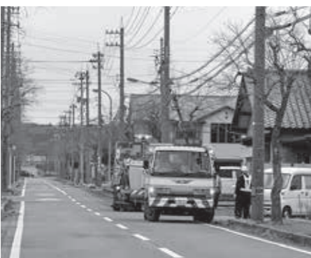
▲道路側溝の整備作業の様子
