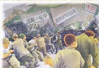
㉓建物強制疎開で僕の家が壊された
