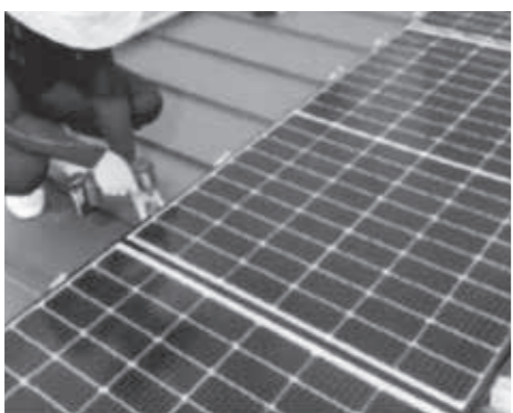
▲ 住宅屋根へ太陽光パネル設置
