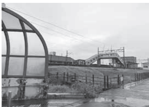
▲春江駅東側の現況（令和6年12月）
