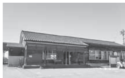
▲再整備が期待される丸岡駅周辺
