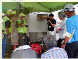
発電機の動作を確認
