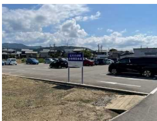
■越前島橋駅 P&R 駐車場整備
