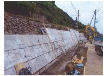
■小舟渡駅付近法面補強
