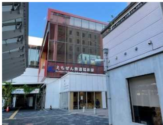
■福井駅の駅舎改修
