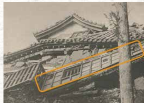
福井地震で倒壊した天守 （『重要文化財丸岡城天守修理工事報告書』 （昭和30年）より転載）
