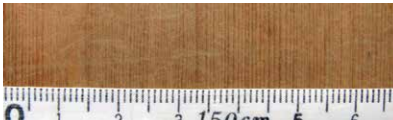
実際に現在使われている天守3階床板の年輪。わずか1ミリの間に複数の年輪が確認できます。
