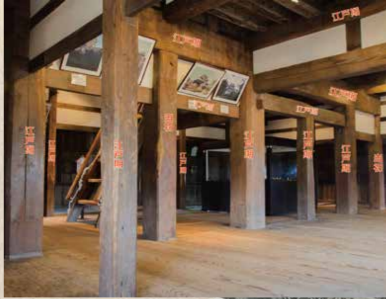
丸岡城天守1階中央の柱 柱や梁など、多くの部材は江戸時代からのものを利用している。
