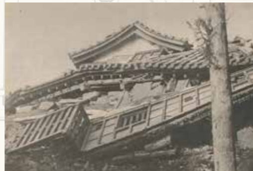
福井地震で倒壊した天守（『重要文化財丸岡城天守修理工事報告書』（昭和30年）より転載）
