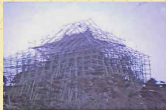
足場を組んだ天守 (1941) 【光山フィルム】
