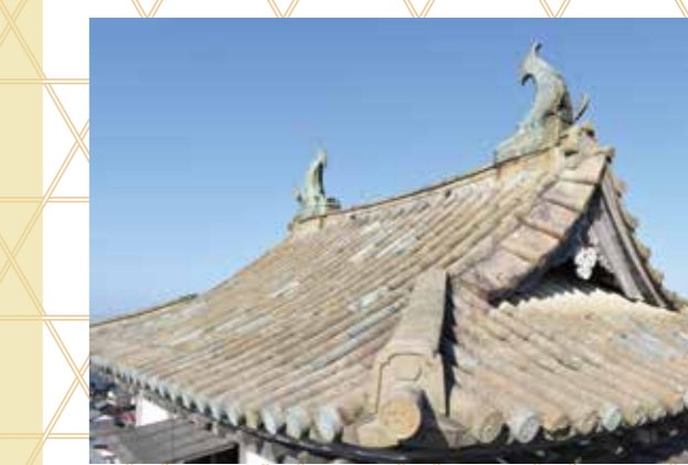
現在の丸岡城天守の屋根 瓦の多くは滝ヶ原石ですが、写真で青みを帯びた石は笏谷石です。
