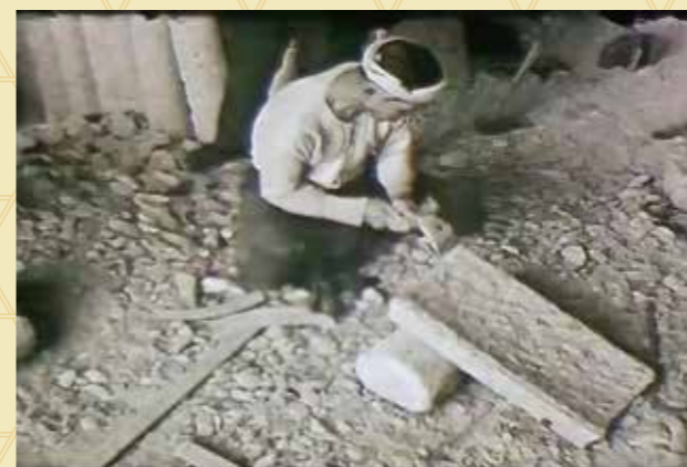
石瓦加工の様子 (石川県小松市滝ヶ原) 【光山フィルム】
