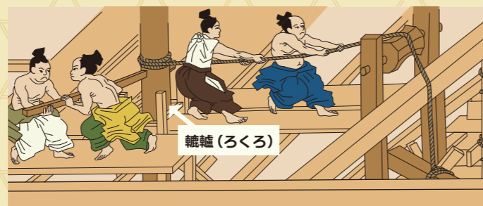
轆轤を巻き上げ材木を持ち上げる様子 (『法然上人絵伝 巻十九』をトレースして作成)
