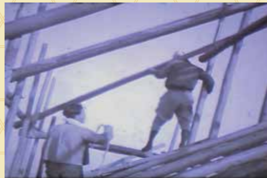
足場上での作業 【光山フィルム】
