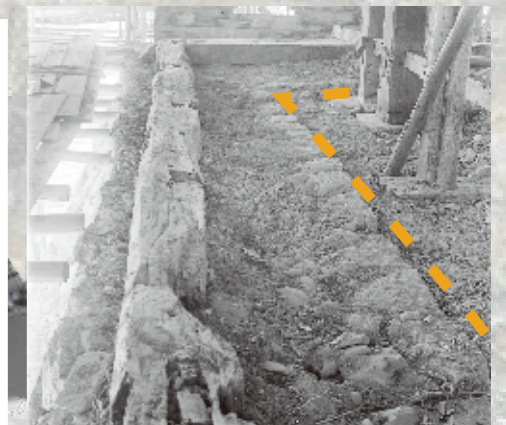
写真は石垣の上面を撮影したもの。石垣の内側に石が並べられていることがわかります。このことから、左の図のように床下に現在よりも広い空間があった可能性があります。
