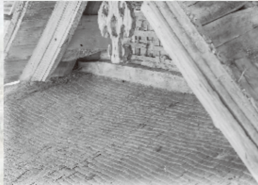
こけら葺きの一部が残っている様子が撮影されています。
