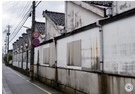
①旧島崎家住宅離れ位置図 ②旧島崎家住宅離れ外観 ③旧島崎家住宅離れ内部(洋室) ④高岡市戸出地区の戸出物産倉庫 (ノコギリ屋根)
