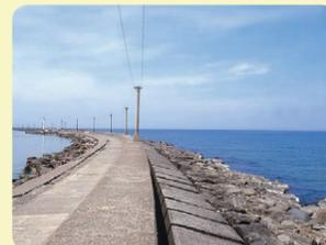
北前船の出入りを改善するため、九頭竜川河口に築造された西洋式突堤。
