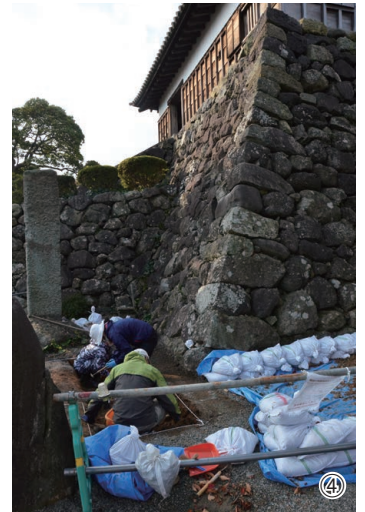
④天守台北東角の調査の様子 「一筆啓上」の石碑の裏。普段人があまり近づかない場所
