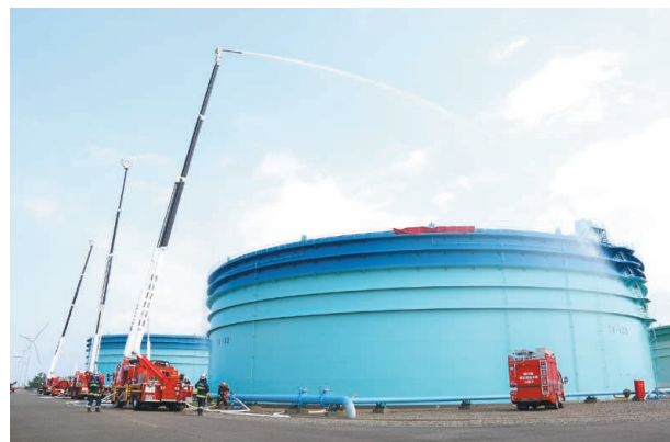
▲石油備蓄タンクに向けて一斉放水する消防車両
