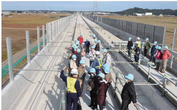
▲工事発注者の鉄道・運輸機構と当該区間の工事受注者が、高架橋の構造などについて説明した
