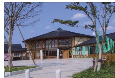
▲交流ホールの増築と直売所の増築のため、改修工事を行っている「いねす」
