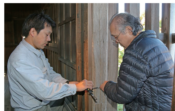
▲時代によって柱の寸法などを定めた木割書が存在する。また、柱の仕上げに用いられた道具も時代によって異なる
