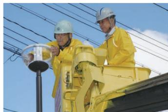
▲作業車を使った照明部分の清掃。汚れがひどいところはカバーを外して拭き取った
