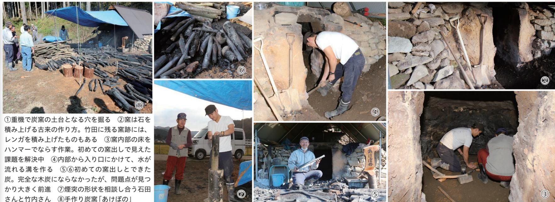
①重機で炭窯の土台となる穴を掘る ②窯は石を積み上げる古来の作り方。竹田に残る窯跡には、レンガを積み上げたものもある ③窯内部の床をハンマーでならす作業。初めての窯出しで見た課題を解決中 ④内部から入り口にかけて、水が流れる溝を作る ⑤⑥初めての窯出しとできた炭。完全な木炭にならなかったが、問題点が見つかり大きく前進 ⑦煙突の形状を相談し合う石田さんと竹内さん ⑧手作り炭窯「あけぼの」
