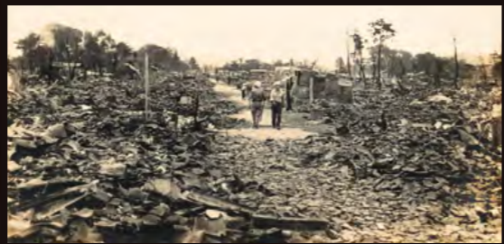
▲福井地震による火災で焼け野原となった、丸岡町の市街地。一面のがれきが、東日本大震災被災地のそれと重なる
