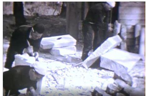
石瓦の製作作業
