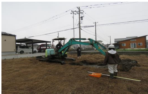
試掘調査の様子
