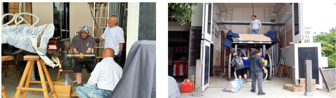
山車解体現場
