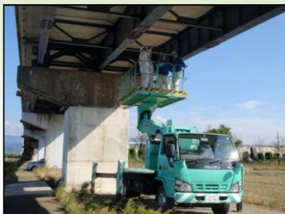
高所作業車による点検
