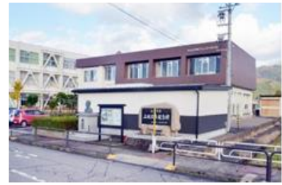
図 5-5 PPA 事業による太陽光発電設置 （のうねの郷コミュニティセンター）
