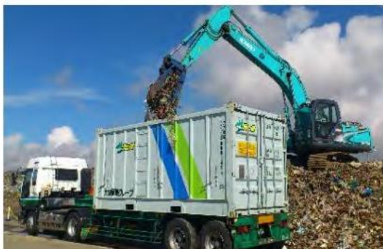
仮置場での海上コンテナへの積込
