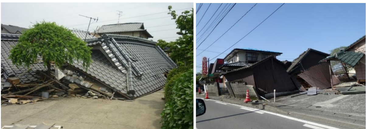
図1-1-1 地震災害による被害状況（平成28年5月 熊本県）
