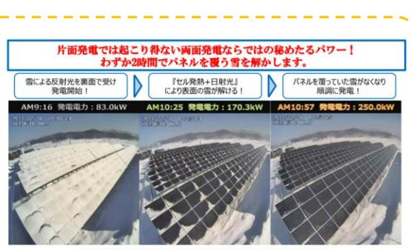
図 2-25 雪の反射面でも発電できる両面発電
