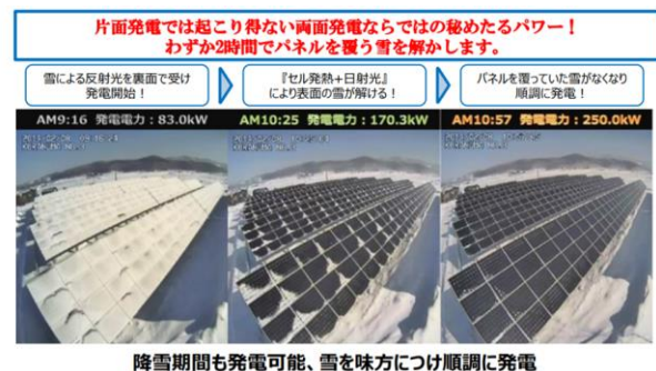
図 2-25 雪の反射面でも発電できる両面発電 [出典] (株) 北海道 PVGS
