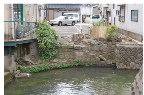
水路として残る外堀の跡
