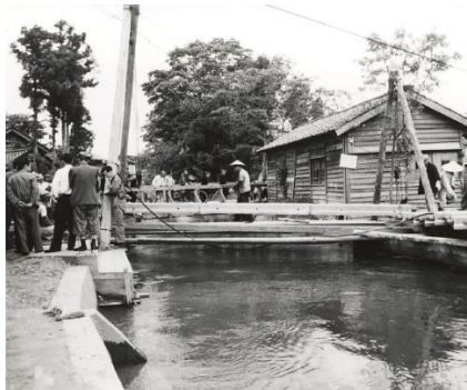
架設作業の様子 (株式会社日本ピーエス HP より)
