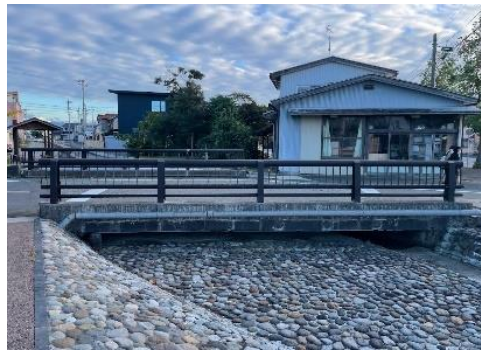
現在の十郷橋 (用水路を埋めたことにより 橋の下の底が浅くなっている)
