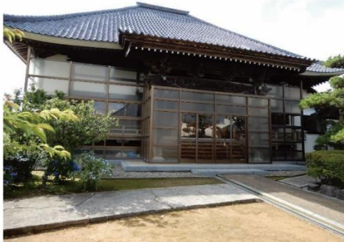
本堂外観・向拝組物虹梁
