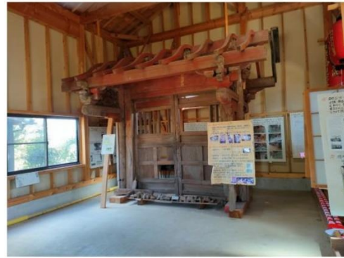
坂井市指定文化財「観音院の門」全景 (左側貝形柱欠失)
