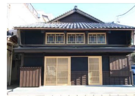
改修し活用した空き家の例
