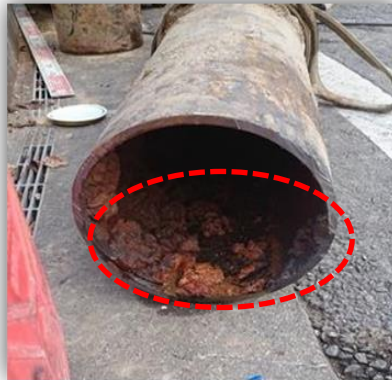
水道管の内部の状況
