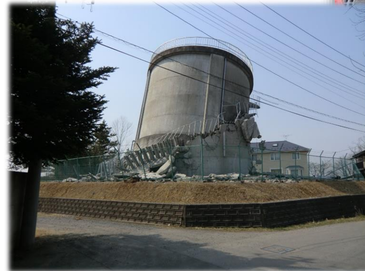
岩手県一関市 沢配水池
