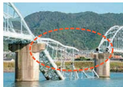
老朽化により倒壊した水管橋
