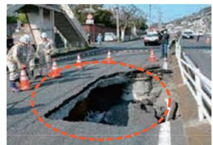
下水道管の老朽化による道路陥没事故
