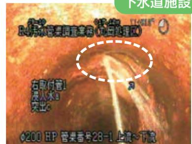
下水道管の老朽化によるヒビ割れからの浸水
