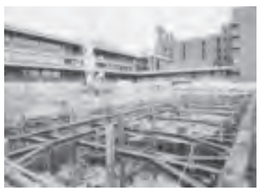
▲弘前市庁舎工事現場
