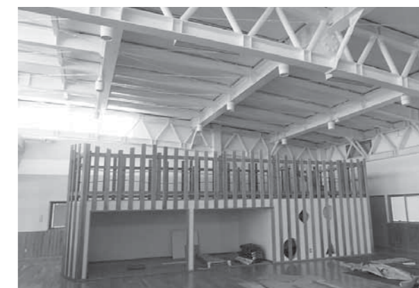
▲建設中の坂井こども園内部
