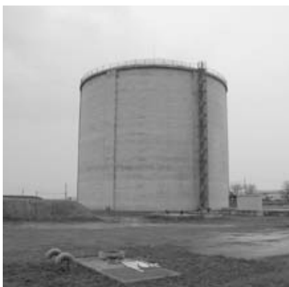
▲ 坂井町定旨の調圧水槽
