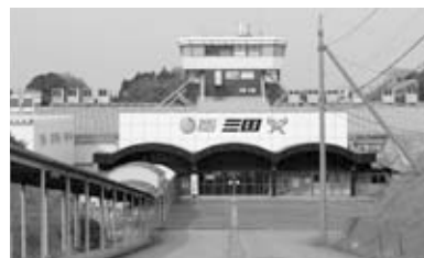
▲ 三国ボートレース場 入口
