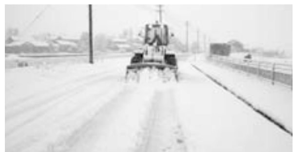
▲道路除雪作業
