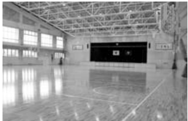
▲耐震改修された三国中学校体育館
