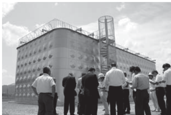
▲ 建設中の東二ツ屋貯水地
