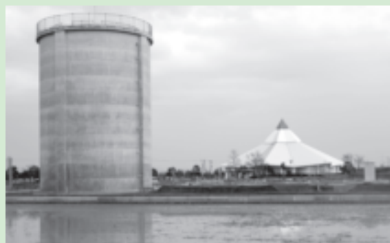
▲ゆりの里公園と調圧水槽(春江北部)
