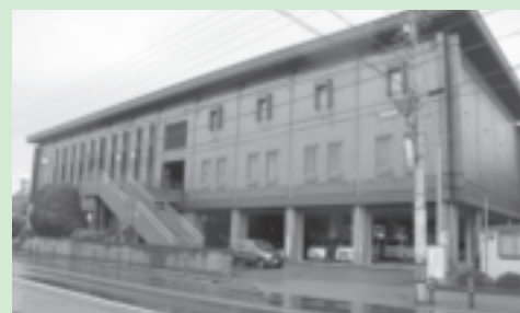
▲耐震診断予定の三国公民館
