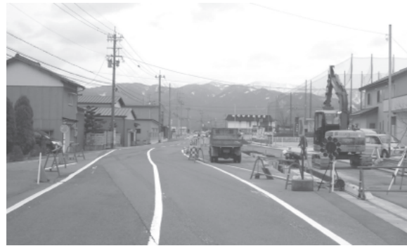
▲末政随応寺線道路整備工事(丸岡町高柳地係)
