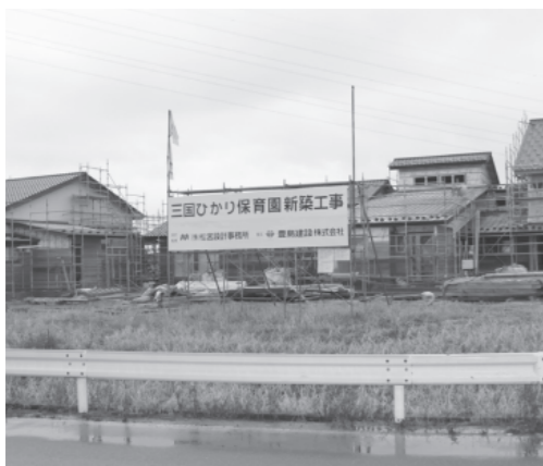
▲建設中の三国ひかり保育園
