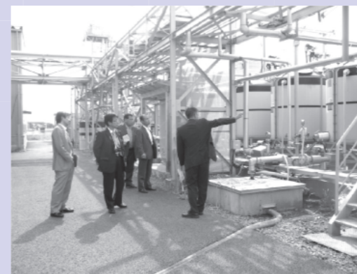
▲エタノール製造プラント(潟上市)
