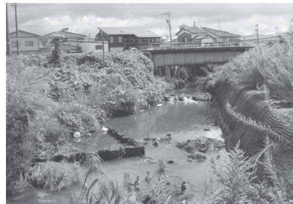
▲JR橋下改修工事予定箇所
