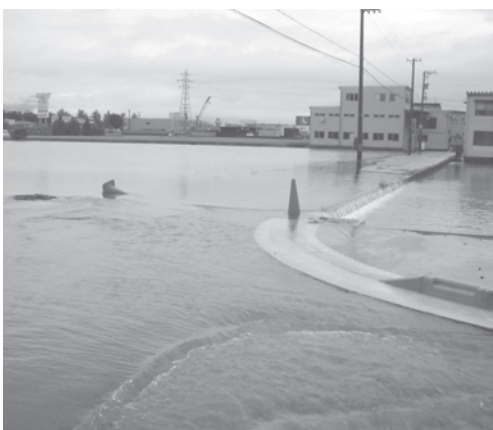
▲国道8号線付近の冠水被害(上安田地係)
