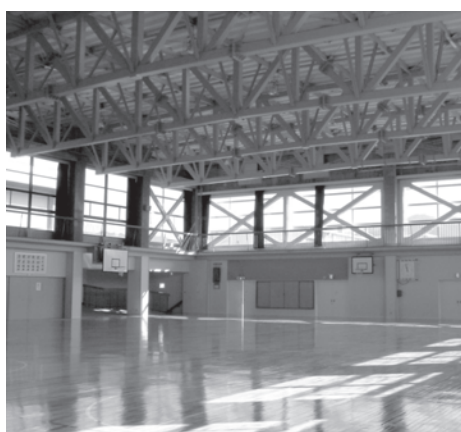
▲平章小学校体育館における耐震補強
